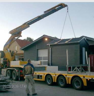
Færdigbygget pumpehus afhentes fra vores værksted
