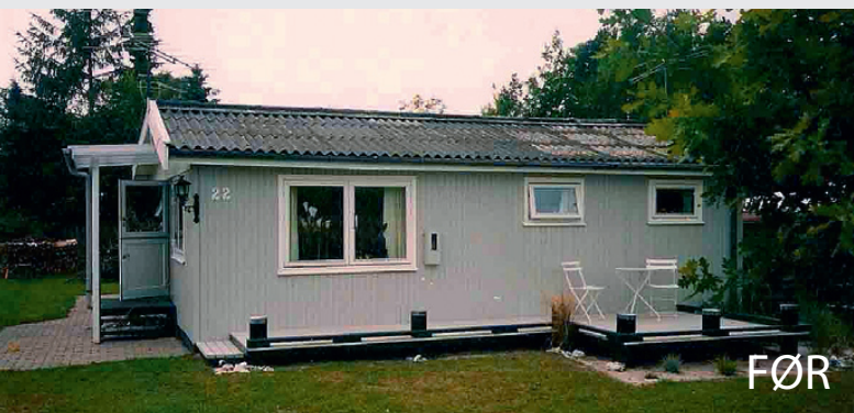
Sommerhus i Fjellerup – før ombygning
