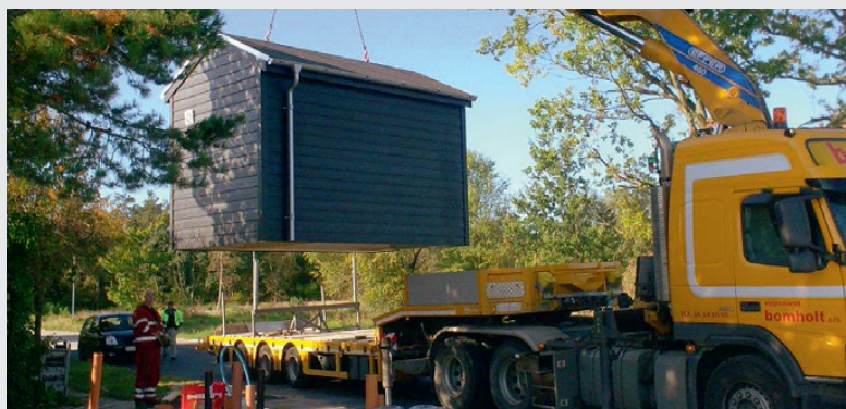
Her løftes pumpehuset på plads
