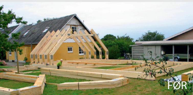
Ny tagkonstruktion opbygges i haven
