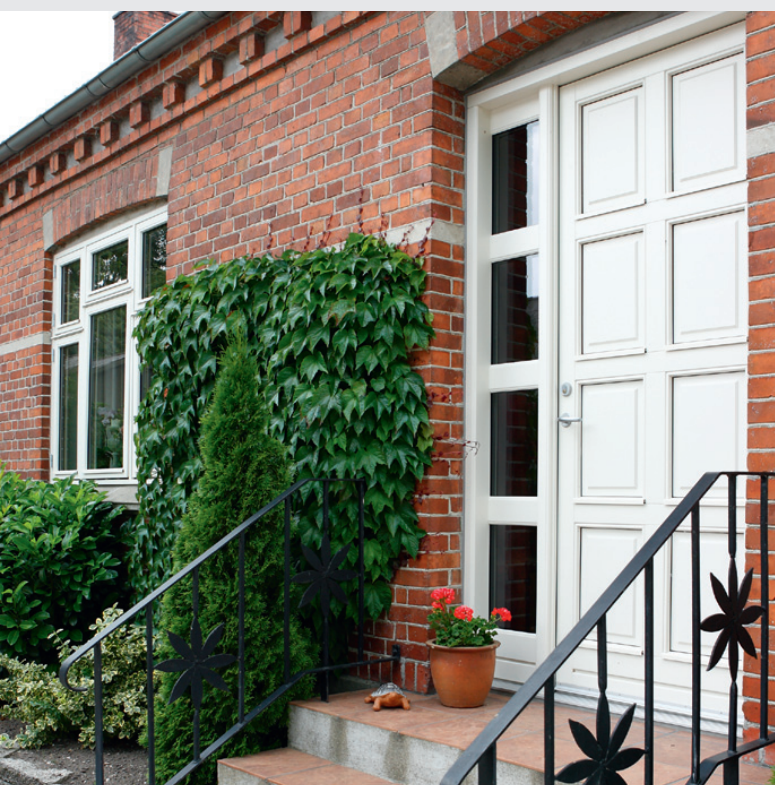
Udskiftning af døre og vinduer
